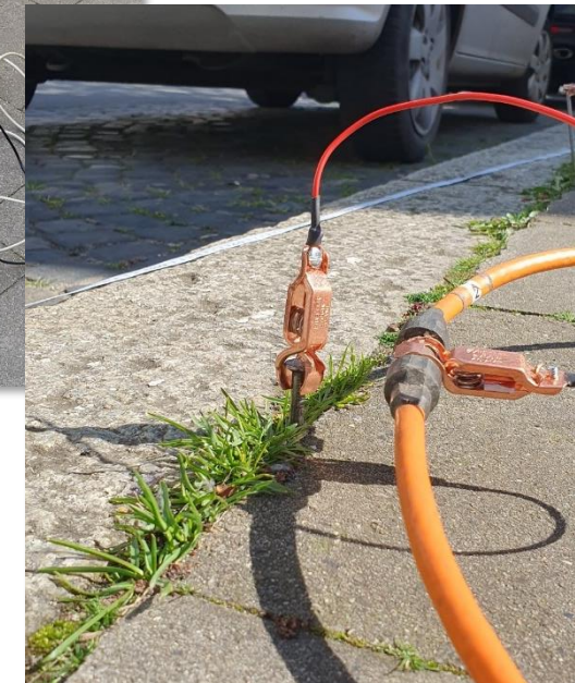
Ankopplung der Elektroden an das Kabel
